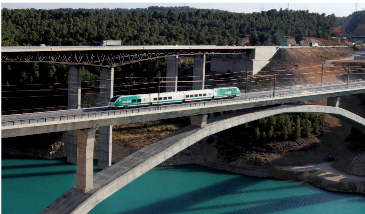
Fig. 10. Viaducto de Contreras, en la LAV Madrid-Valencia.
