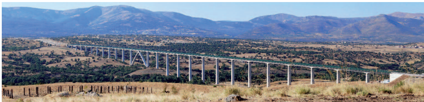
Fig. 8. Viaducto de Arroyo del Valle, en la LAV Madrid-Valladolid.
